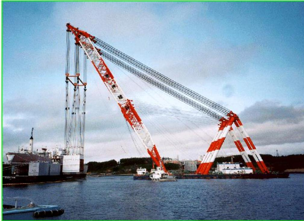
図7 切断された原子炉室の吊り上げ（出典：日本原子力研究所）
